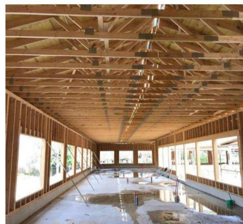
Un des chantiers en cours de Durand Charpente, société spécialisée notamment dans les constructions ossatures bois.
