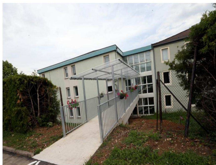
Des grands chantiers à ceux plus modestes, comme cette passerelle qui relie les hôtels Ibis Styles et Relais Vert au Pied des Gouttes à Montbéliard.
