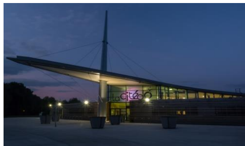
Complexe Aquatique du Pays de Montbéliard Agglomération à Sochaux ML 02 : Gros oeuvre/Fondations spéciales/charpente métallique/Bassins inox (5 227 000,00 € HT)
