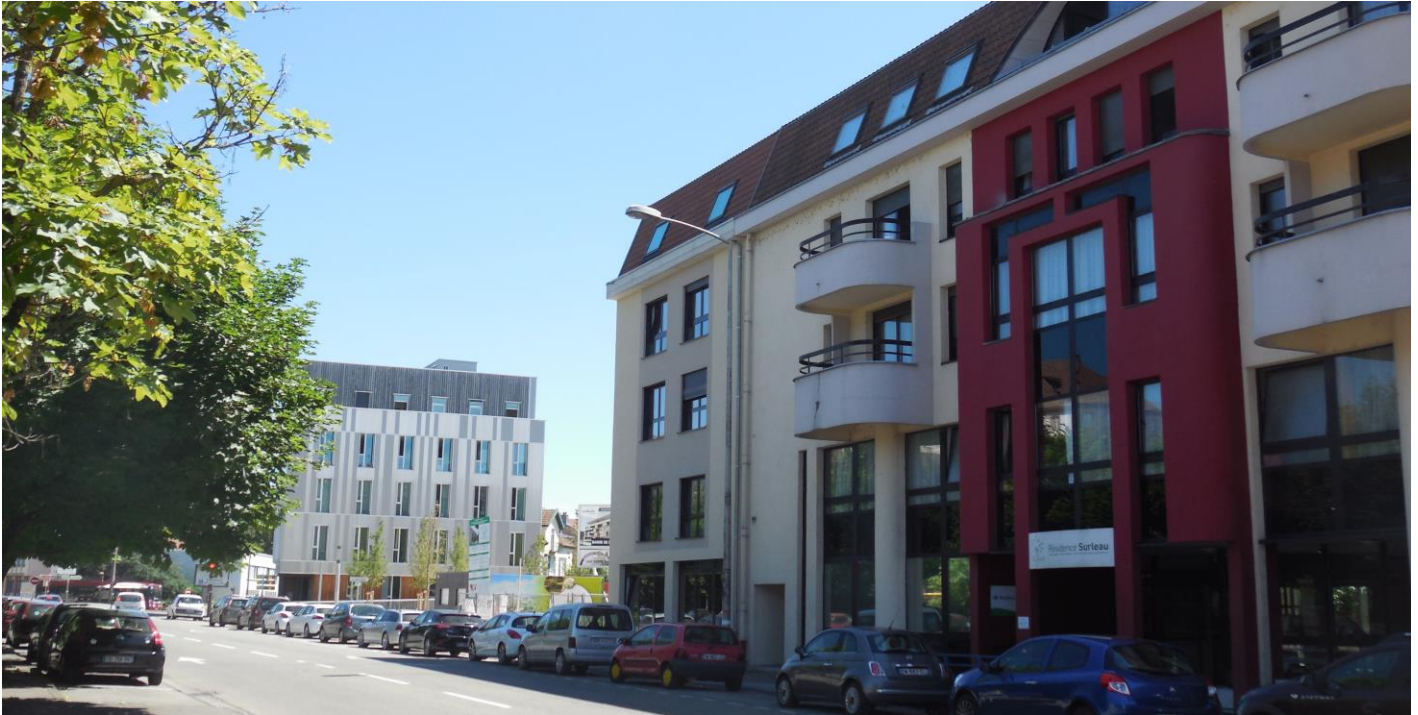
EHPAD SURLEAU A MONTBELIARD Fondation Arc en Ciel
